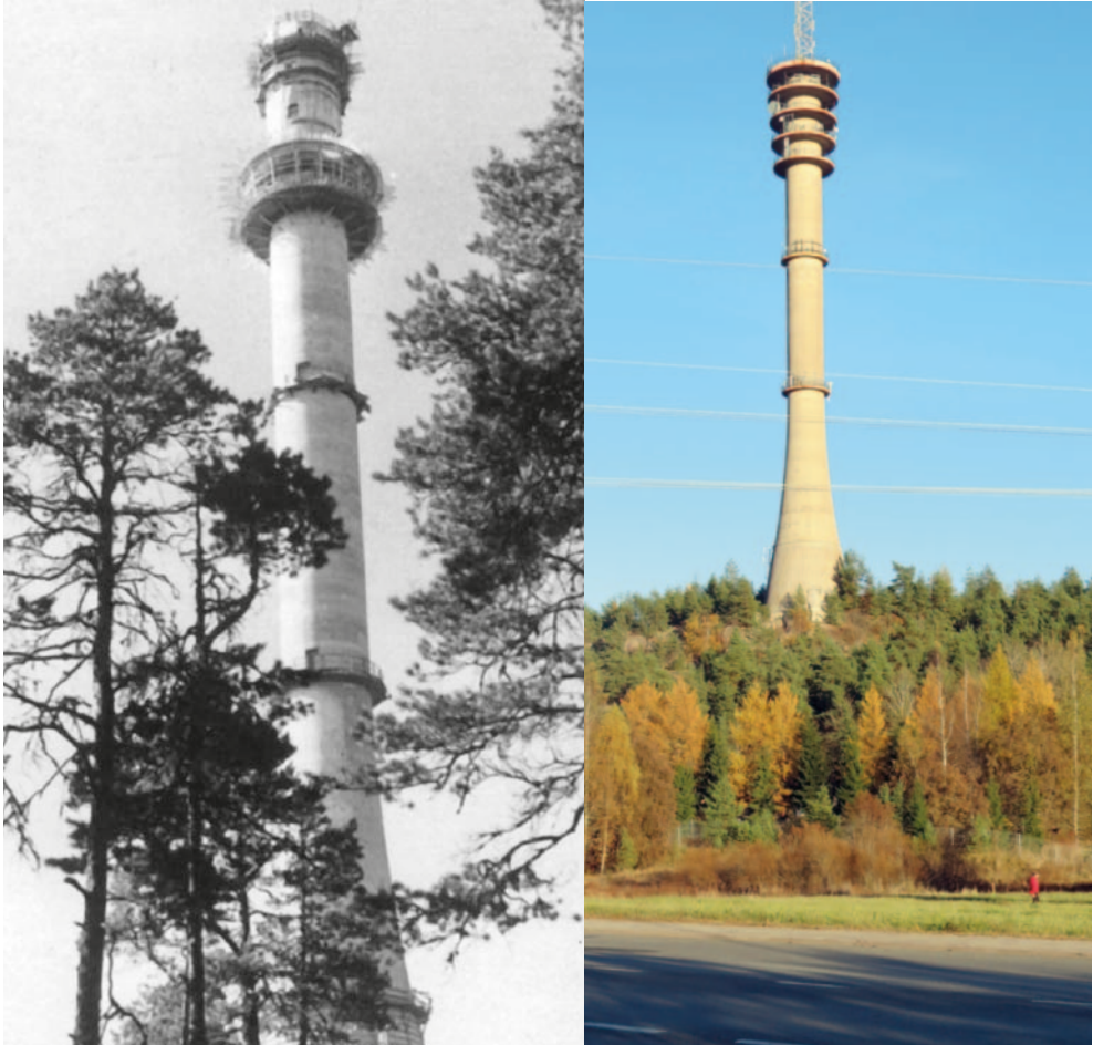
Linkkitorni rakennusvaiheessa 1961, kuva Alfons Grönberg ja nykyisin, kuva Merja Kokkala.
