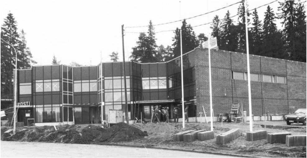
Linkkihallin rakennustyömaa. Tähän rakennukseen muutti myös Posti.
