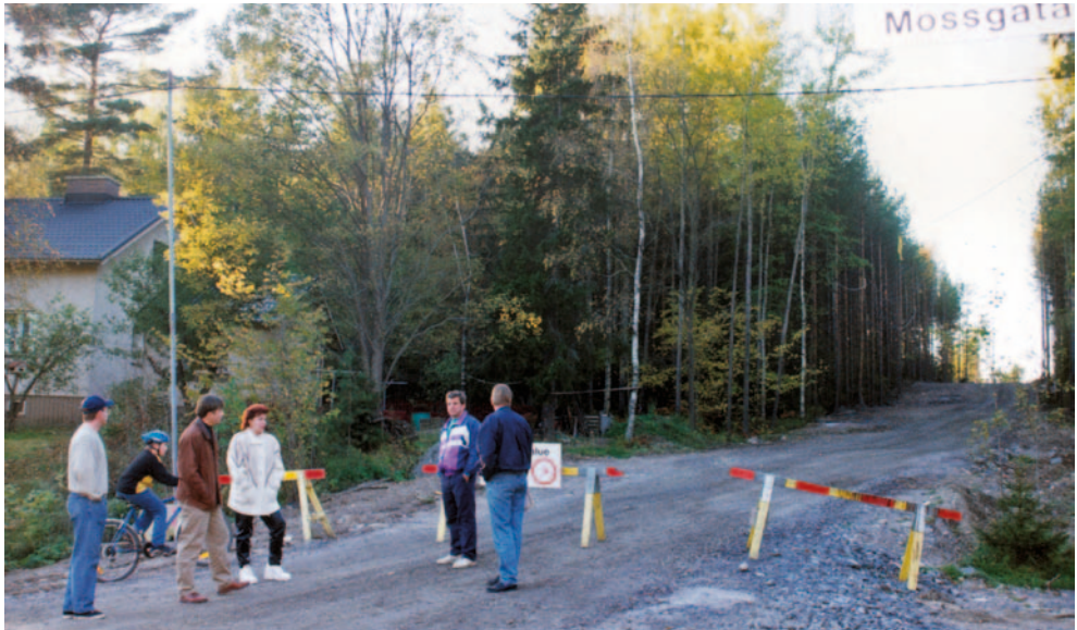
Suokadun asukkaita yhdessä omakotiyhdistyksen johtokunnan kanssa tutustumassa rakennusalueelle johtavaan väliaikaiseen, viemäriinjalle rakennettuun tiehen, jota pitkin kuorma-autot kuljettivat raskaita kuormia rakennusalueelle ja sieltä pois. Kuva Sirkeka ja Lasse Miettinen
