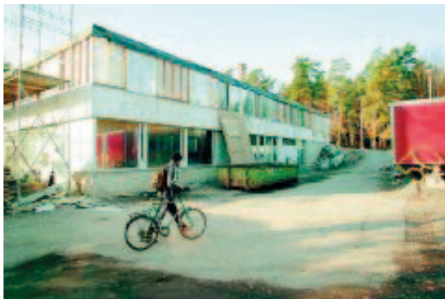
Pääskyvuoren koulua remontoidaan. Kuva Kulmakunta.
